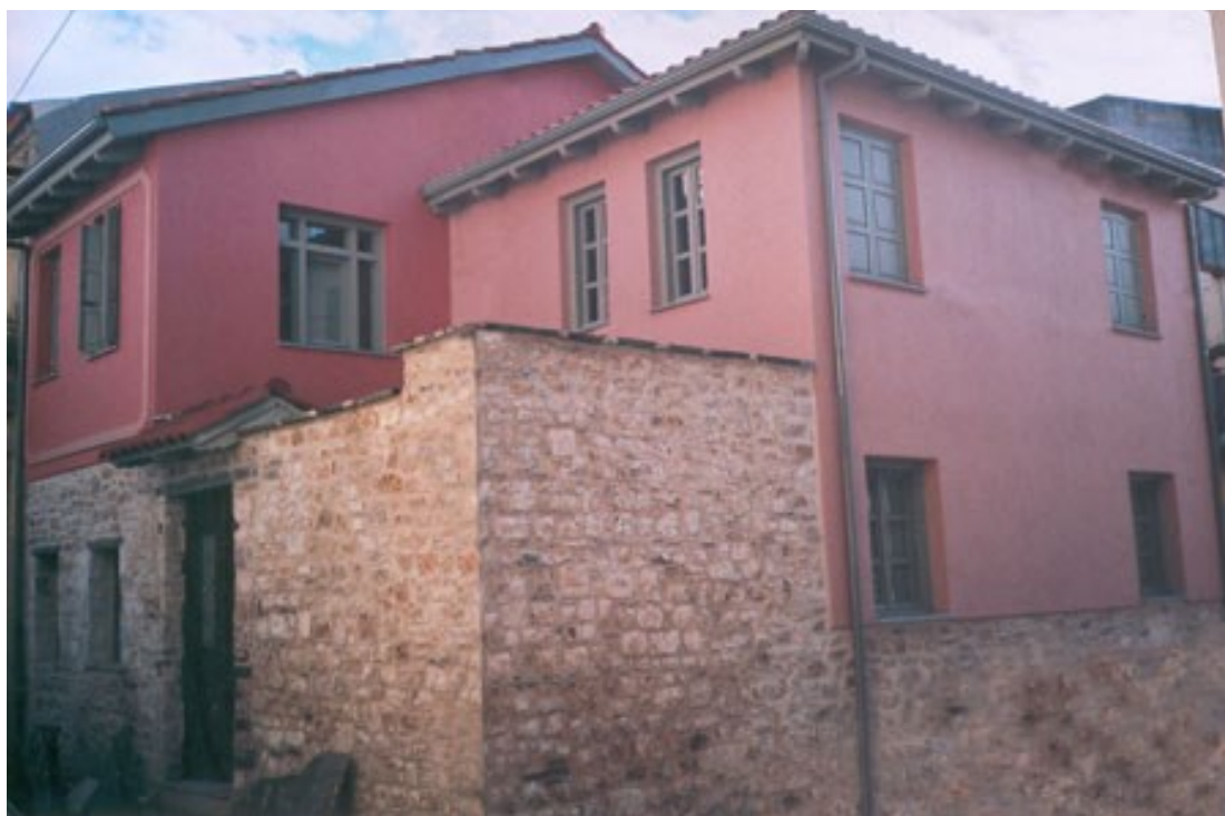
Εικόνα 3:5 Το οίκημα Μάτσα, 150 χρόνια μετά την κατασκευή του, στην σημερινή του μορφή ως ξενώνας.
