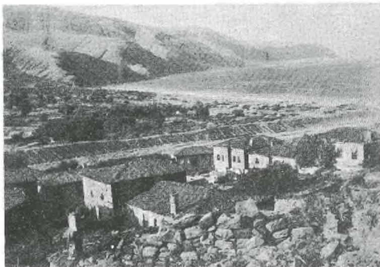
ΓΑΝΟΣ. Ὁ πίσω μαχαλᾶς μὲ τὸ ρέμα πού κατεβαίνει ἀπὸ τὸν Ἄη Γιώργη τοῦ Μηλιοῦ. Ἡ κοίτη του ἔχει ἀναχώματα γιὰ προστασία ἀπὸ πλημμύρα. Ἀπέναντι τὰ βουνὰ τοῦ Βαρδαλάκου (Αὐδήμιον).
